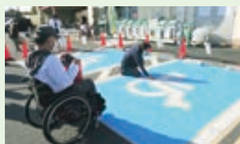
▲塗装作業の様子
