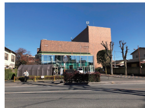
②パルシティ通り（既存市民会館）
