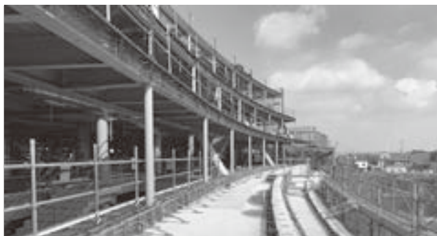
▲2階南側テラス施工状況(令和3年10月撮影)
