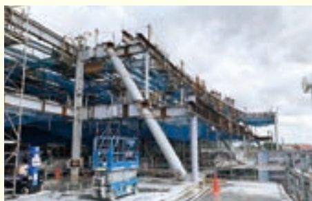
▲柱・梁組立て状況(令和3年9月撮影)
