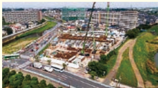
◀6月22日(火) 敷地南側より撮影
