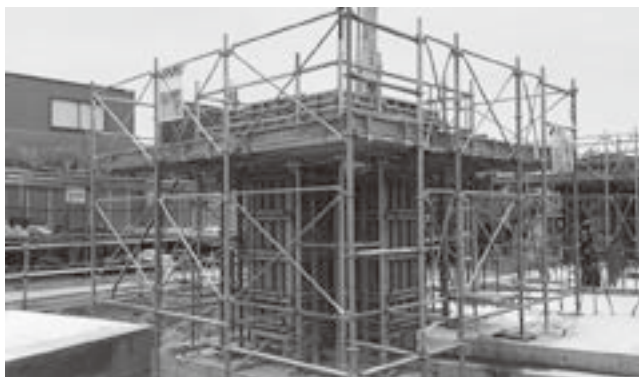
▲地下1階柱及び免震装置下部躯体の型枠組立状況(令和3年5月撮影)
