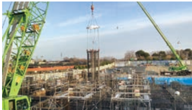
▲基礎躯体工事の様子(令和3年2月撮影)
