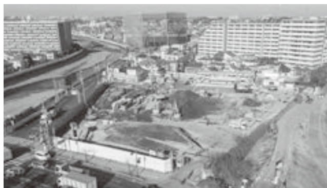
▲敷地南側から撮影(令和3年1月末撮影)
