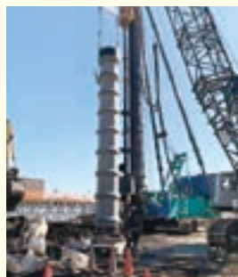
◀新庁舎を支える長さ30m、太さ1.2mの杭(12月撮影)
