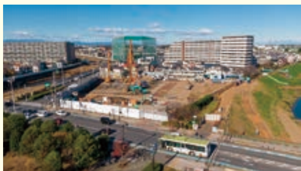
▲旧庁舎の解体後、更地となった敷地全体の様子(11月撮影)
