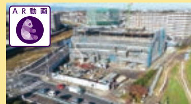
▲敷地南側上空からの様子(令和3年11月撮影)
