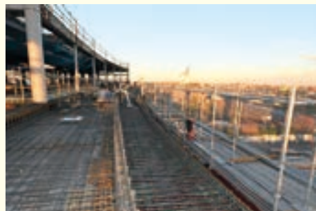
◀4階テラス配筋状況 (令和3年11月撮影)
