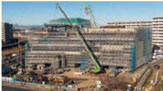
▲令和3年12月敷地南側から撮影
