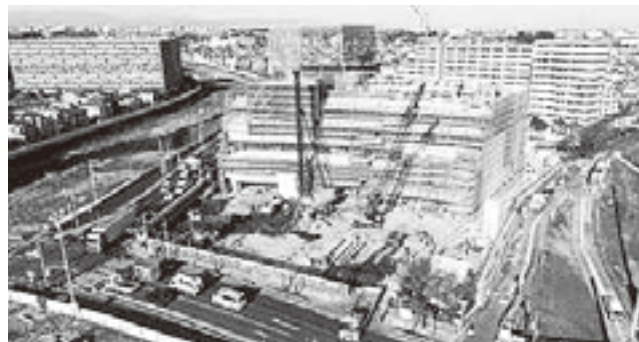
▲令和4年1月敷地南側から撮影
