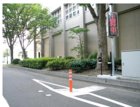
図 ソフトライジングボラード 設置の実証実験（埼玉大学構内） 出典：久保田教授提供資料
