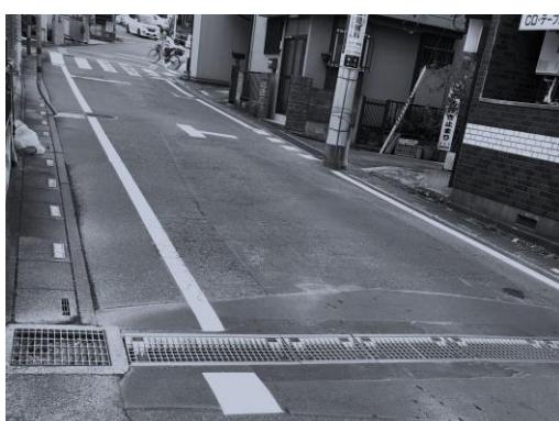
水害対策「道路横断側溝」
