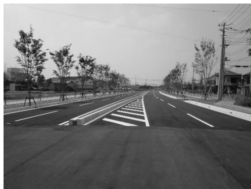
一般国道 254 号バイパス（モデル工事区間）
