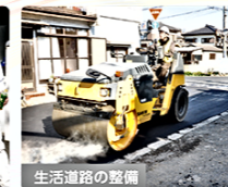
生活道路の整備
