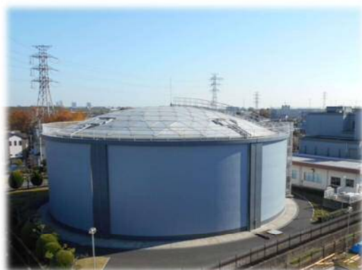
【写真 2-1 宗岡浄水場 No. 1 配水池】
