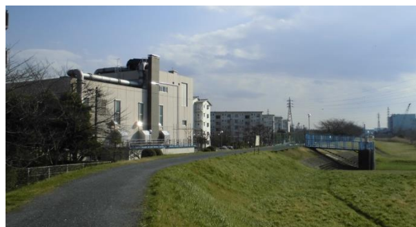
■ポンプ場外観および樋管ゲート
