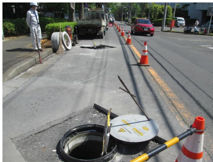
汚水マンホール蓋の交換のようす
