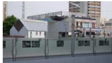
図 4-11 ペDESTロリアンデッキ
