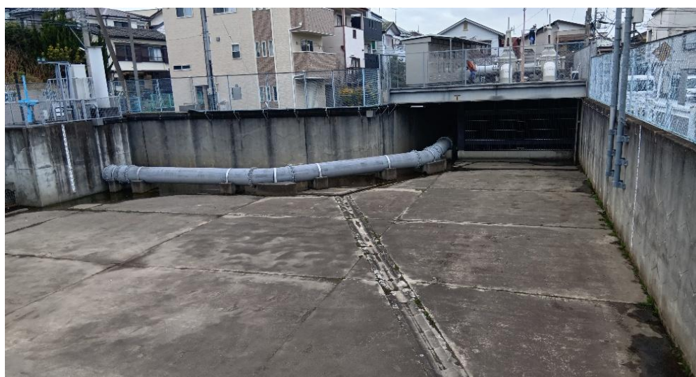
図 15 調整池貯留槽
