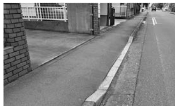
▲切り下げ工事後
