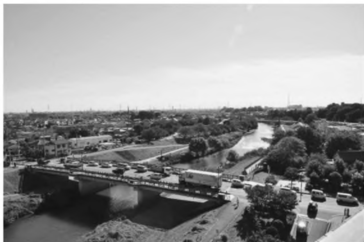
市役所屋上から見た新河岸川
