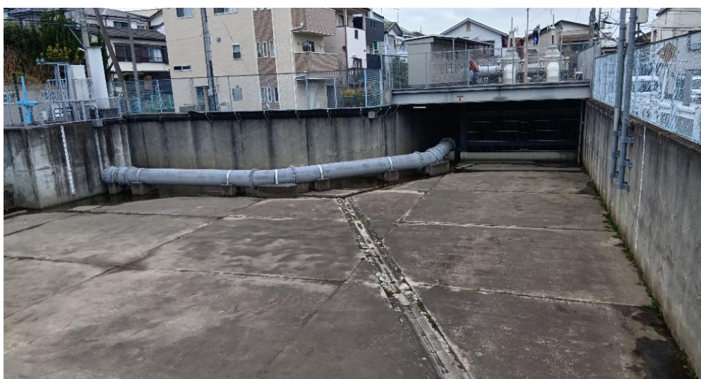
図 15 調整池貯留槽
