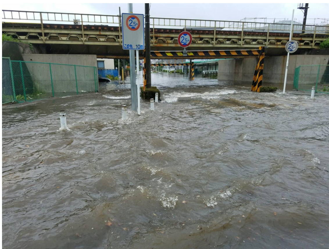
図1 志木市 浸水被害写真
