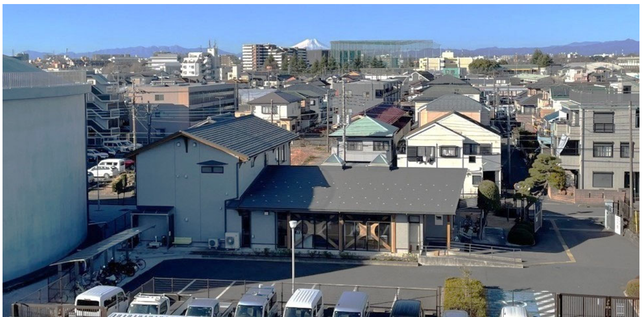
志木市水道庁舎
