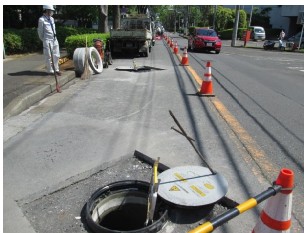
汚水マンホール蓋の交換のようす
