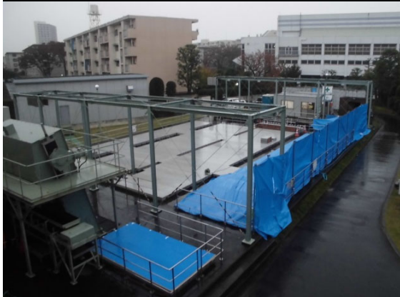
■ポンプ井の耐震工事（館第一排水ポンプ場）
