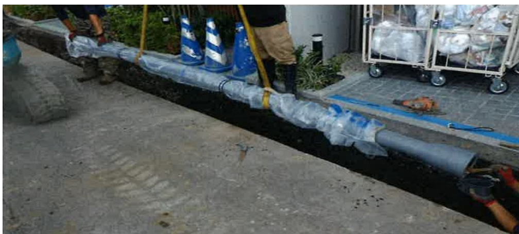
配水管整備のようす
