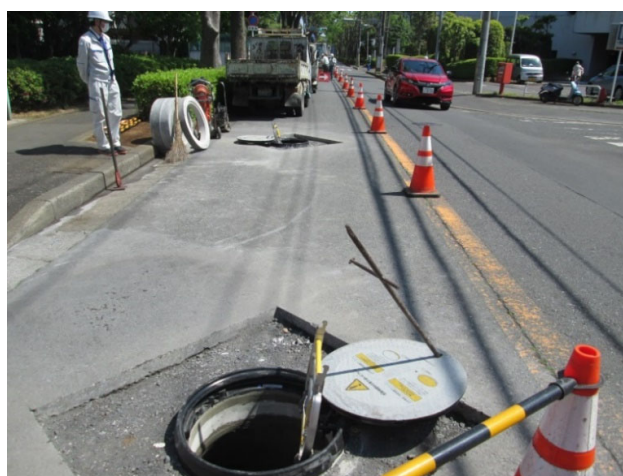
汚水マンホール蓋の交換のようす
