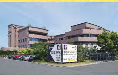
恵愛病院全景/駐車場250台
