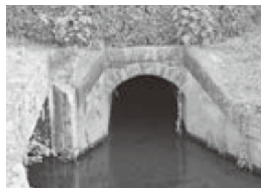
▲堤内側からみた籠鳥門樋
