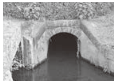
▲堤内側からみた籠 かごしまもんび 門 もん 樋
