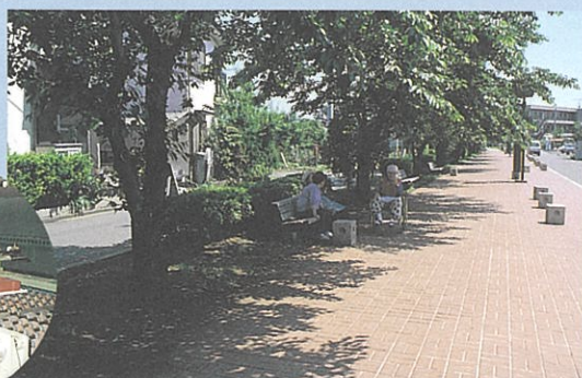
下水道焼却灰レンガ(ドリーム)を施した遊歩道
