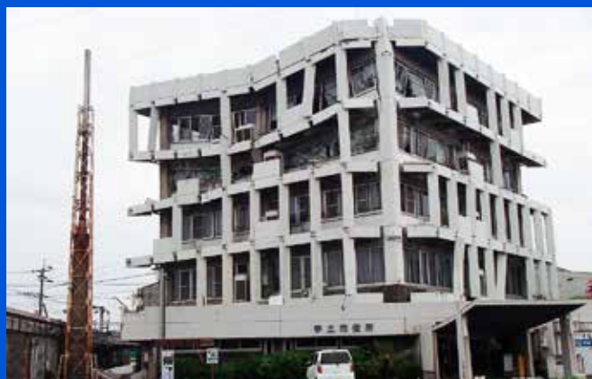
熊本地震で倒壊した市役所庁舎(熊本県宇土市)
