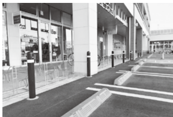
市内商業施設に設置されている車止めポール
