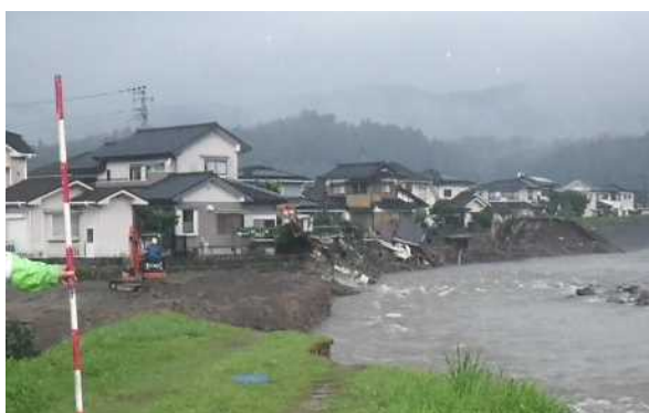
河岸侵食による家屋の倒壊(花月川)
