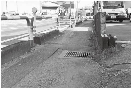
宗岡第二小学校付近の歩道
