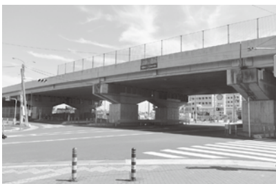
国道254バイパスの立体交差 (富士見市内)
