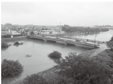
台風9号が通過した時の新河岸川の様子
