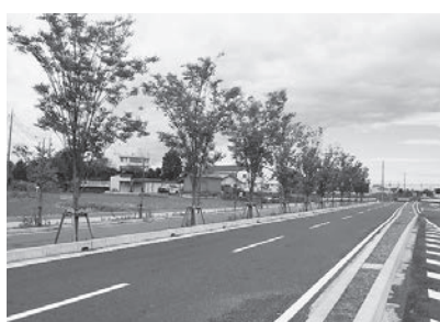
254号バイパス整備地区(下宗岡1丁目)
