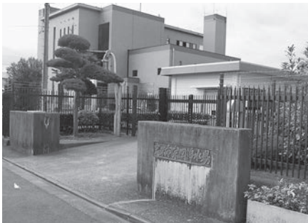
水道水の安定供給を担っている浄水場 (宗岡浄水場)
