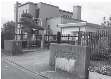
水道水の安定供給を担っている浄水場 (宗岡浄水場)
