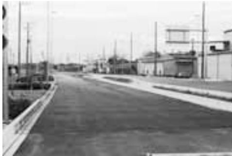
国道254号バイパス第1期整備区間
