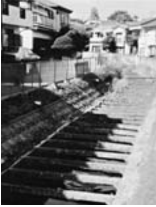
坂下橋下流付近
