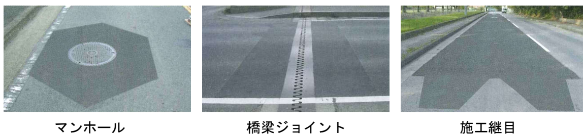
写真 3-2 段差修正工の例
