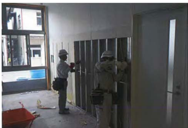
壁・ボードクロスの撤去作業
