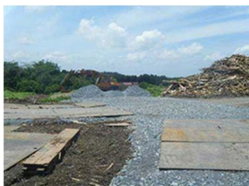
仮置場搬入路敷設の砂利・網板
