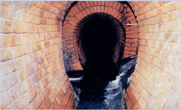
日本初のレンガでつくられた近代下水道(現在も使用) 出典：東京都下水道局
