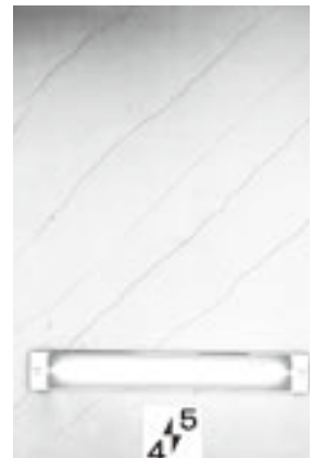
庁舎内の壁のひび割れ
